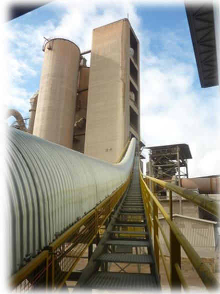
Es en la nave de combustibles alternativos donde se almacenan la biomasa, el orujillo y los combustibles alternativos procedentes de la trituración de los neumáticos. Desde allí, son conducidos a los puntos de alimentación en el intercambiador o en el quemador principal. Además, se emplea gasóleo durante los procesos de arranque y calentamiento del horno.
